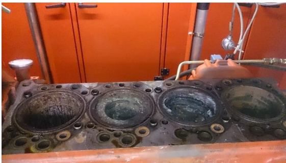
Demontage Zylinderkopf BHKW 1 am 26.06.2015
