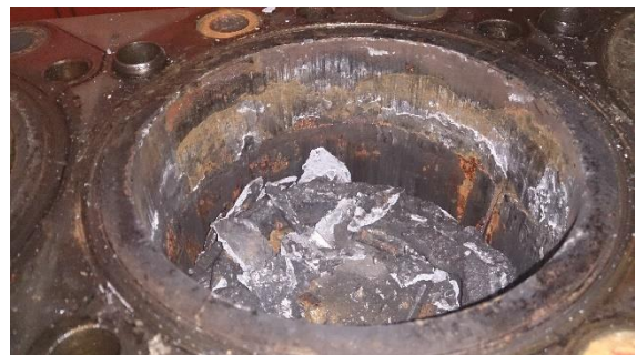
Zerstörter Kolben BHKW 1 am 02.07.2015
