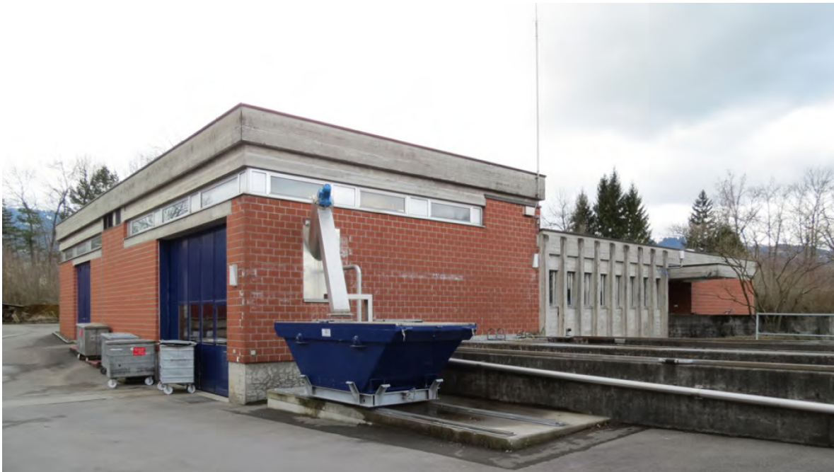
Bestehendes Betriebsgebäude (rechts) mit Rechengebäude (links), 2013
