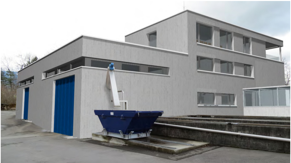
Projekt saniertes und aufgestocktes Betriebsgebäude (rechts) mit Rechengebäude (links)
