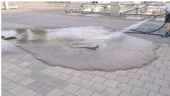
Aufgestossener Schlamm im Vorplatz am 20.06.2014, 07.15 Uhr
