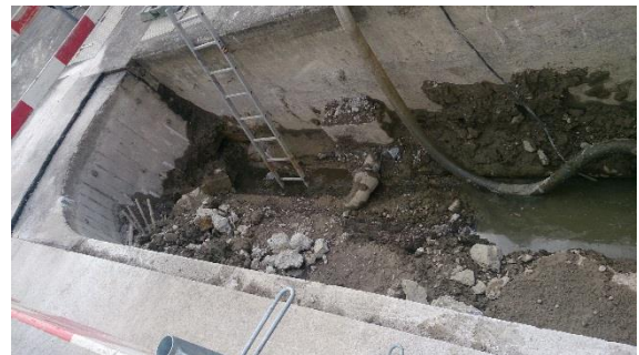
Lecksuche unter beengten Verhältnissen am 20.06.2014, 17.15 Uhr
