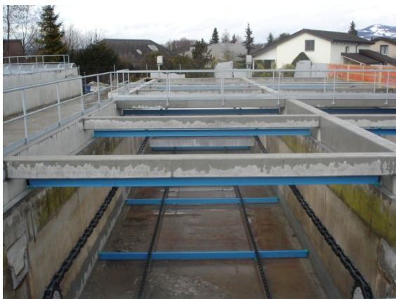
Nachklärbecken leer Aufnahme am 17.02.2006
