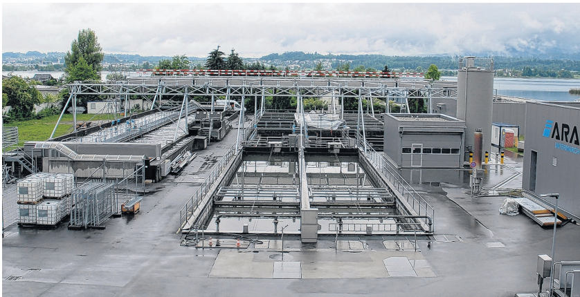
Die Klärbecken und die Photovoltaikanlage (im Bau) der ARA Untermarch, vom Verwaltungsgebäude aus gesehen.
