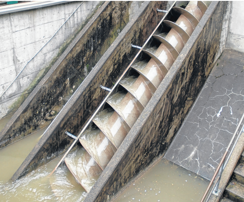
Diese Schmutzwasser-Schnecken können bis zu 300 Liter Wasser pro Sekunde nach oben fördern. Bilder: Urs Attinger
