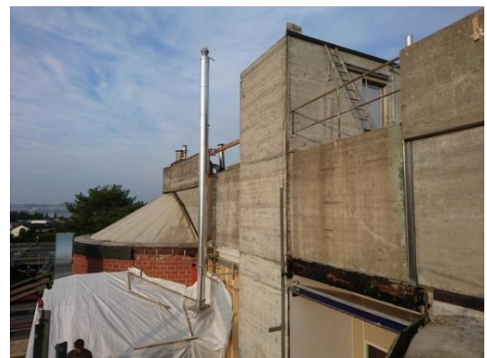
Abbruch roter Turm
