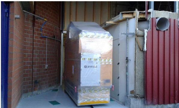
Bild oben: Anlieferung neues BHKW ▲
