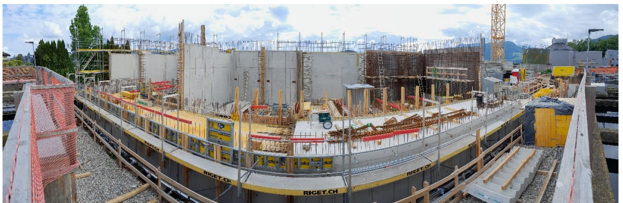
Panoramabild einer Rohbautetappe der Anlage zur Elimination von organischen Spurenstoffen (Mikroverunreinigungen) am 29.05.2022
